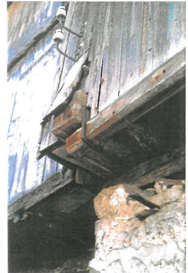
Angle d'un encorbellement montrant la liaison des bois de charpente.
