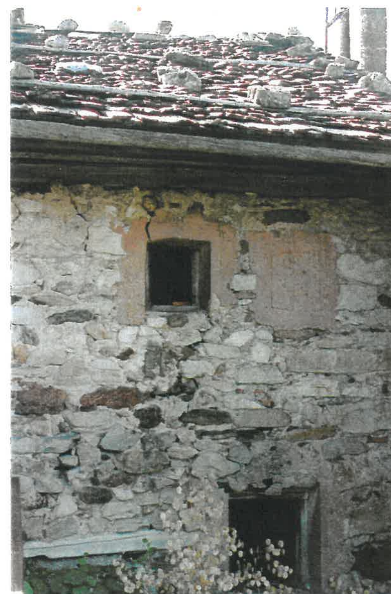
Enduit d'encadrement des ouvertures.
